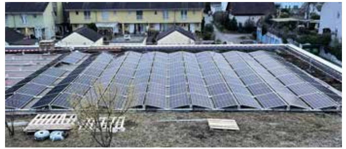
Installation der PV-Anlage 2021.
